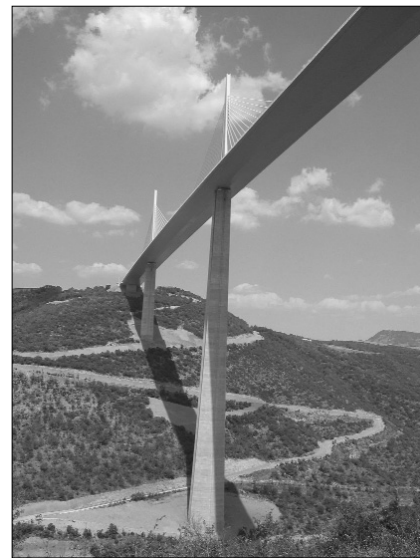
Abb. 1: Die derzeit höchste Autobahnbrücke der Welt überquert im Süden Frankreichs den Flusslauf des Tarn auf einer Strecke von 2,5 km in 270 m Höhe über dem Tal. Funktion und Komplexität eines solchen Bauwerkes lassen sich auf die Anforderungen der Anbindung des Verwaltungsnetzes an Internet-Dienste übertragen. Foto: 2005 Roland Herbst
