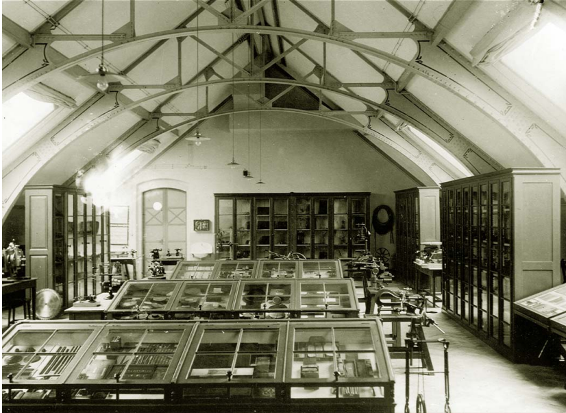
Abb. 2: Typischer Sammlungsraum im Dachgeschoss des Hauptkollegiengebäudes der Mechanischen Abteilung der TH Dresden (Mechanisch-Technologische Sammlung) © Kustodie der TU Dresden
