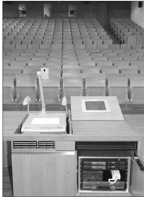
Abb. 6: Festinstallierte Medientechnik im großen Hörsaal
