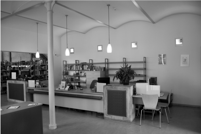
Abb. 2: Dresden, Stadtteilbibliothek Pieschen. Verbuchungstheke in der ehemaligen Remise mit der erhaltenen preußischen Kappendecke der alten Feuerwache. ©J. Tempel.
