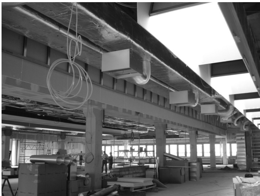
Abb. 2: Nur Stützpfiler strukturieren den ansonsten vollflexiblen Raum.
