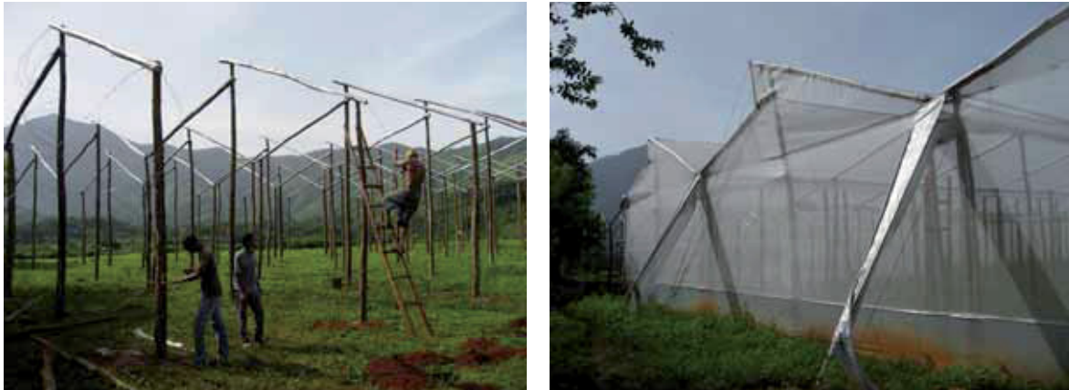
Abbildung 10: Bau der Treibhäuser in Rio Limpio (links), erstes fertiggestelltes Treibhaus (rechts)
