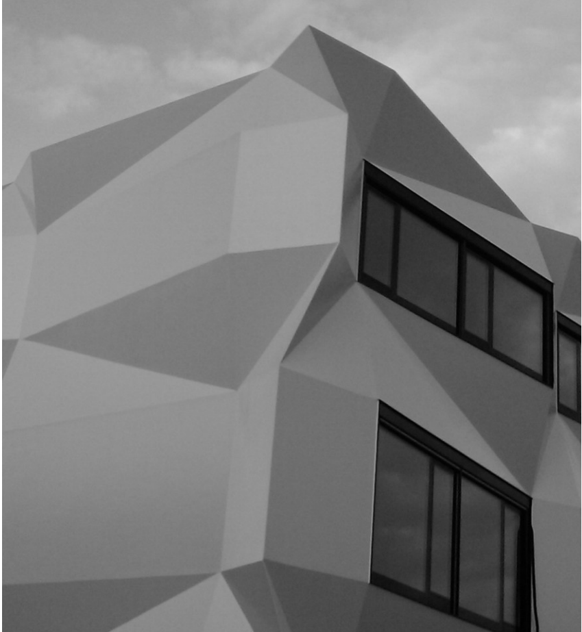
Abb.3: Detail der Fassade. © T. Schelling.
