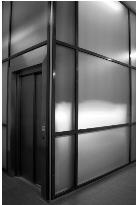
Abb. 2: Augenfälligste Baumaßnahme: der gläserne Aufzug.
