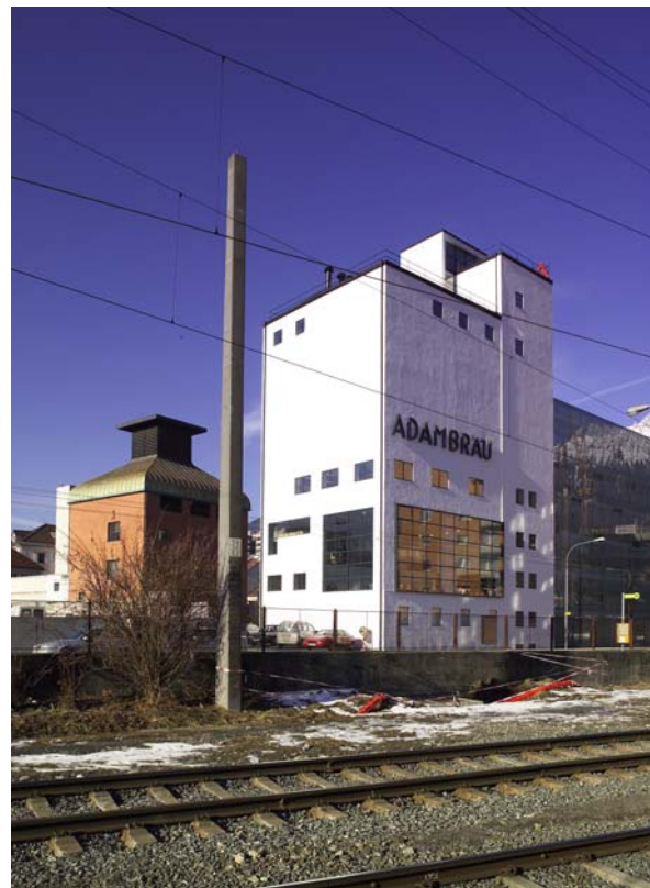
Abbildung 1: Innsbruck, Adambrau von Südosten, Lois Welzenbacher 1926/27
