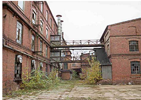
Abb. 8: ehemalige Tuchfabrik Friedrich Schmidt, Hauptproduktionsgebäude (links) mit Stegen zum ehemaligen Tuchlager.
