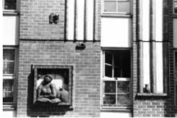
Abb.11: Nördliche Altstadt, Rostock, Fassadendetail.
