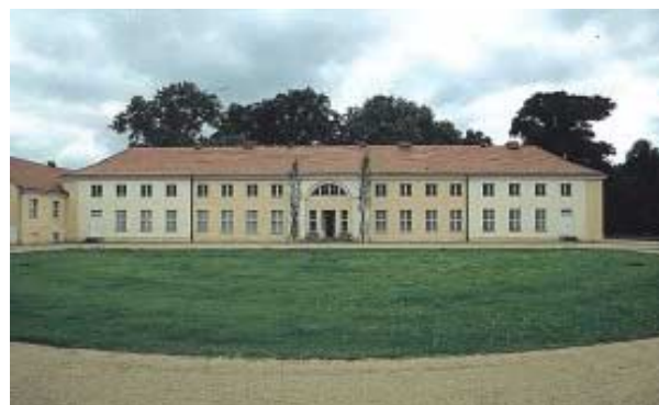
Abb.3: Fassade des Schlosses Paretz nach der Rekonstruktion. Neuer Zustand Juli 2002. Foto Verfasser.
