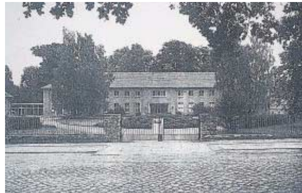
Abb.2: Fassade des Schlosses Paretz vor der Rekonstruktion. Alter Zustand ca. 1990. Quelle: Brandenburgisches Landesamt für Denkmalpflege (Hrsg.): Paretz. Denkmalbereich und Ortsentwicklung, Potsdam 1993, S. 5.
