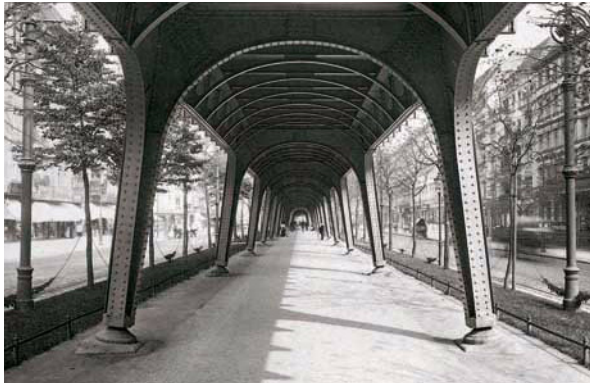
Abb.1: Berlin, Hochbahnviadukt in der Schönhauser Allee.
