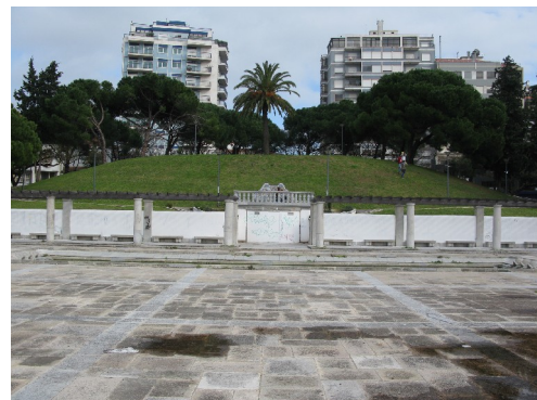
(Abb. 4) Carlos und Guilherme Rebelo de Andrade / Diogo de Macedo / Maximiliano Alves / Jorge Barradas, Fonte Lu-minosa , 1943, Stahlbeton, Kalkstein, glasierte Keramik, (Detail), Lissabon. (Jakob Hartmann)
