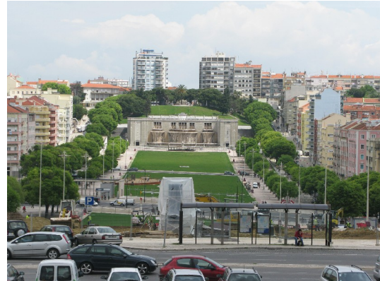
(Abb. 2) Carlos und Guilherme Rebelo de Andrade / Diogo de Macedo / Maximiliano Alves / Jorge Barradas, Fonte Luminosa , 1943, Stahlbeton, Kalkstein, glasierte Keramik, Lissabon. (Jakob Hartmann)
